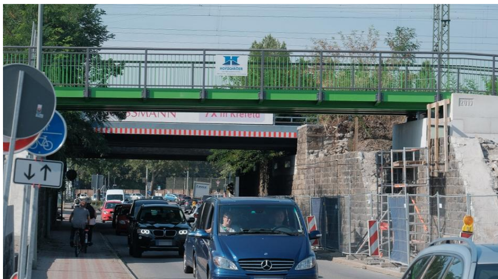
Die neue Stahlträgerbrücke über den Dießemer Bruch ist jetzt montiert worden. Foto: Stadt Krefeld/LOTHAR STRUECKEN
