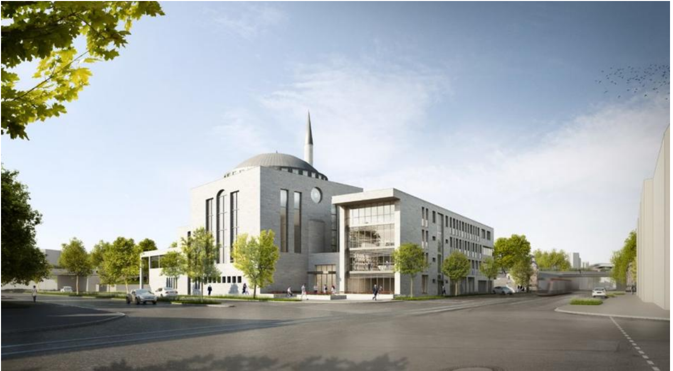
Foto: Ditib / Architekt Nihat
